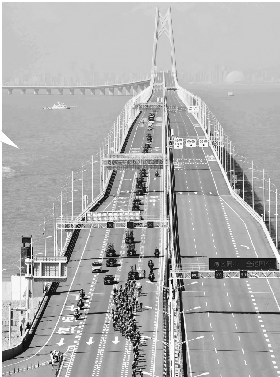
11月8日10时24分，选手通过港珠澳大桥白海豚人工岛。南方日报记者 张由琼 姚志豪 石磊 苏韵桦 董天健 关铭荣 摄
